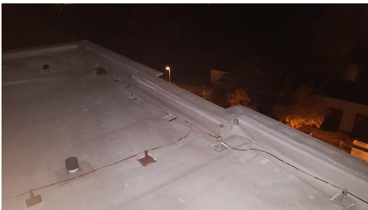
Obrázok č.17 - Pohľad na riešenie atiky, v pozadí je vidieť strešný vpust
