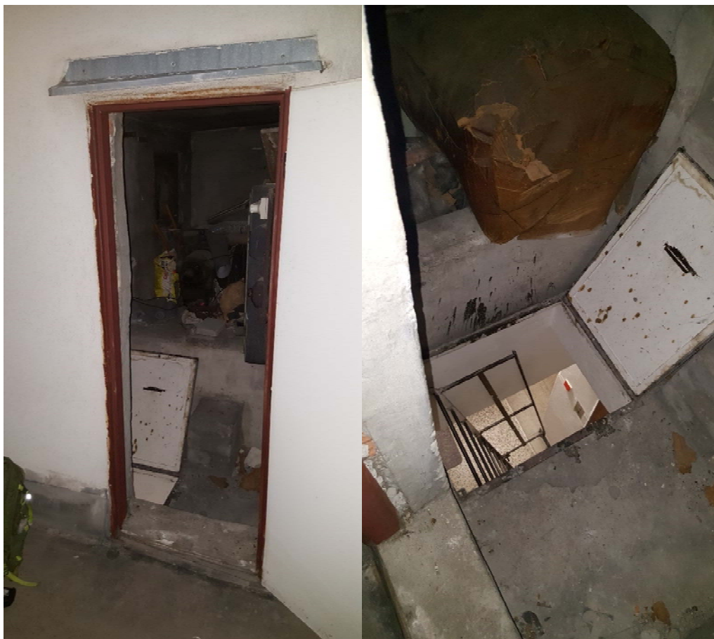
Obrázok č.18 a 19 - Pohľad na vstup do strojovne výťahu a pohľad na výlez do strojovne zo schodiskového priestoru na 5. nadzemnom podlaží
