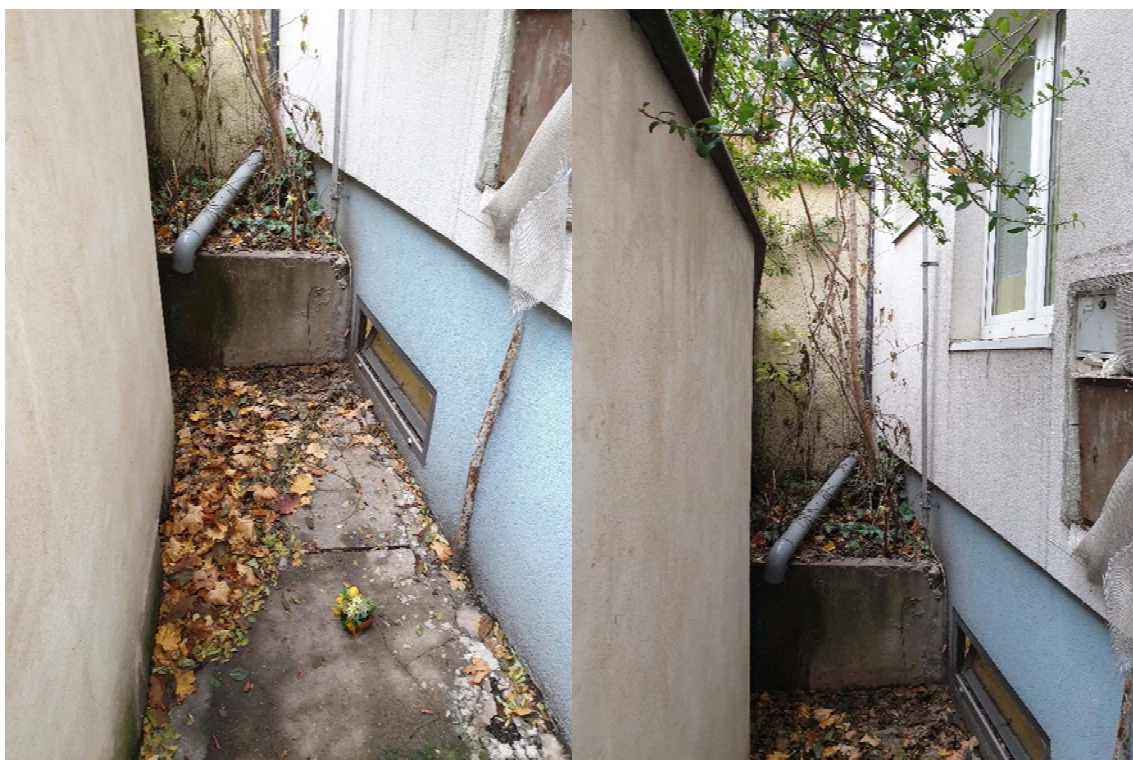
Obrázok č.11 a 12 - Pohľad na dvor a dvorovú fasádu stavebného objektu SO 01, vyvýšený záhon nie je hydroizolačne oddelený od objektu, zemina je v kontakte s keramickými materiálmi z čoho vznikajú poruchy v miestnosti 1.04 a 1.05
