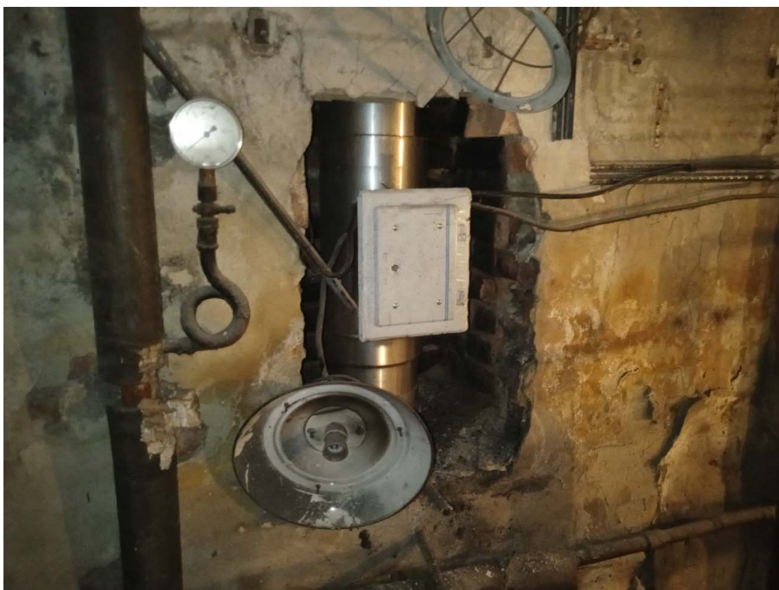
Obrázok č.52 - Pohľad na vybudovaný nový komín pre novú kotolňu (miestnosť 0.09) v 1. podzemnom podlaží
