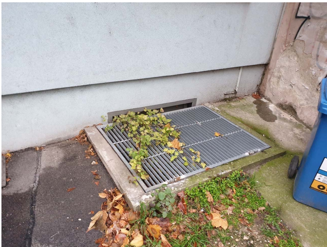
Obrázok č.7 - Pohľad na anglický dvorec na uličnej fasáde, slúžiaci na odvetranie kotolne
