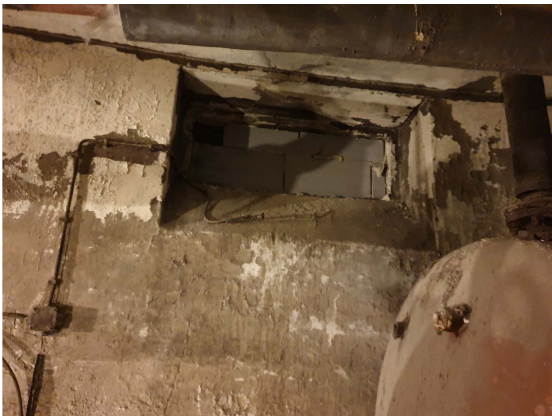
Obrázok č.53 - Pohľad na zamurované pôvodné okno v miestnosti starej kotolne (miestnosť 0.09) v 1.podzemnom podlaží
