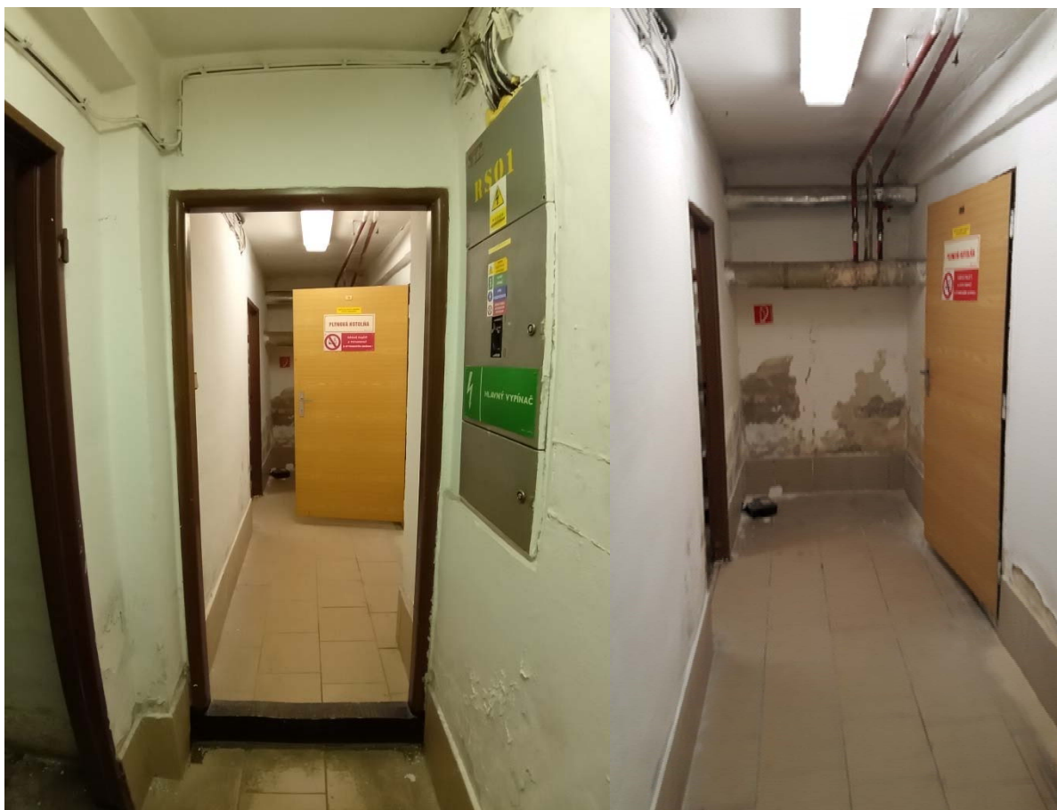
Obrázok č.26 a 27 - Pohľad na chodbu v 1. podzemnom podlaží, vidieť narušenú povrchovú úpravu stien od vlhkosti (miestnosť 0.02)
