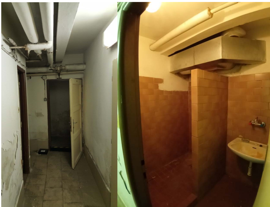
Obrázok č.44 a 45 - Pohľad na chodbu (miestnosť 0.05) a pohľad na kúpeľňu (miestnosť 0.10) v 1.podzemnom podlaží, v kúpeľni je vidieť napojenie plynových kotlov na komín
