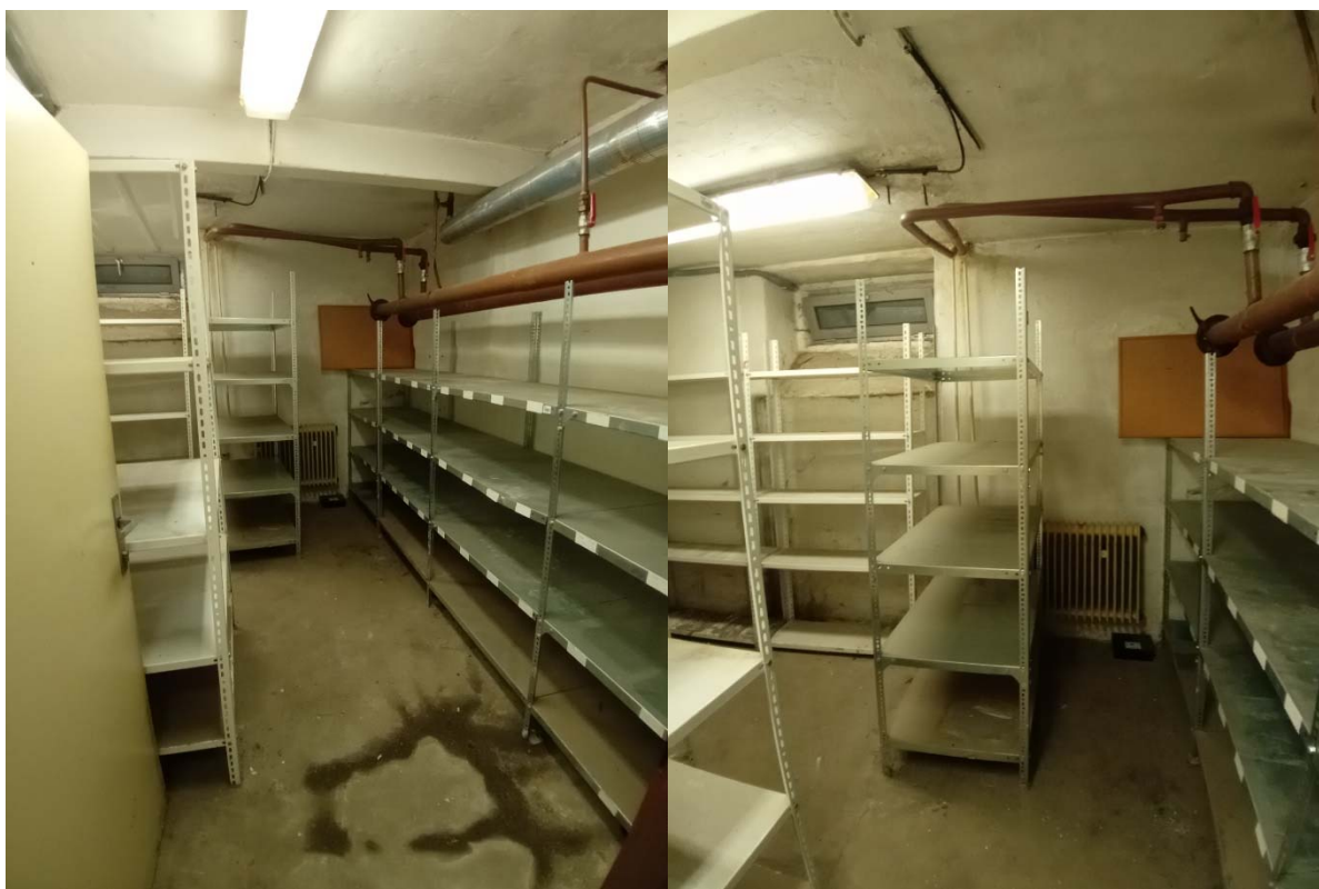
Obrázok č.28 a 29 - Pohľad na miestnosť v 1. podzemnom podlaží, vidieť vlhkosť v konštrukcii podlahy (miestnosť 0.03)
