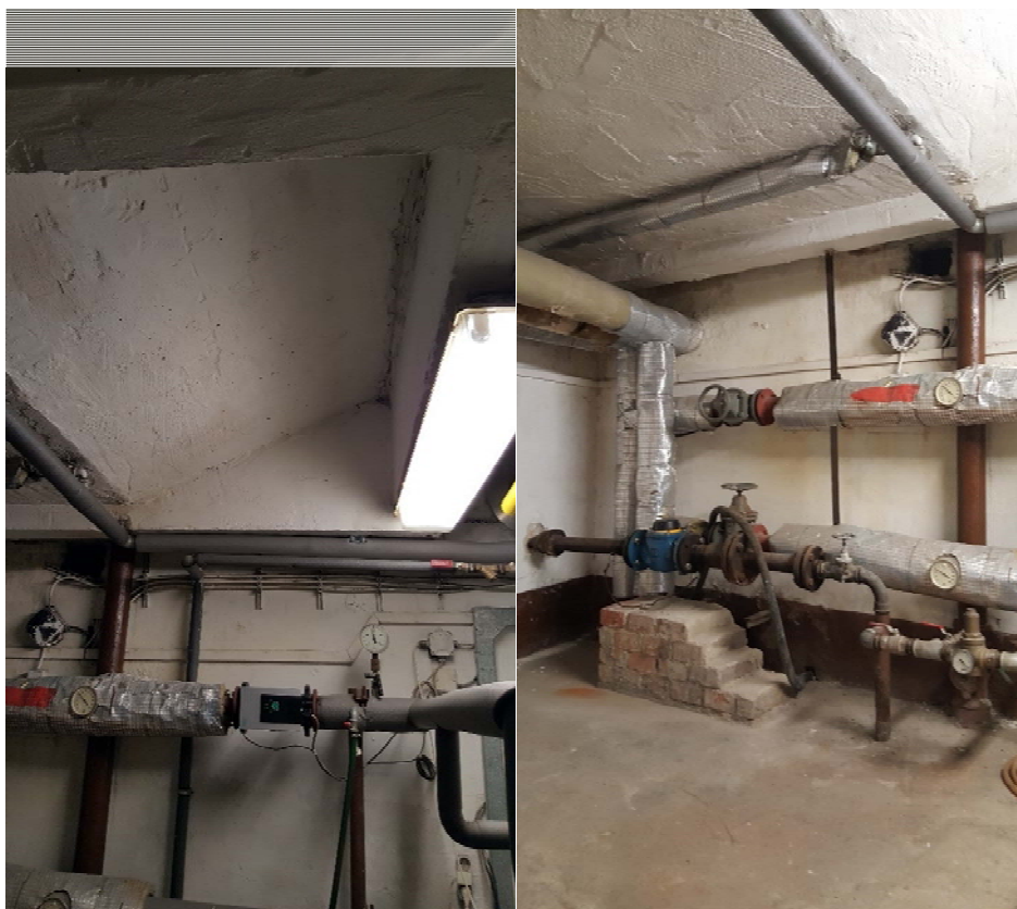
Obrázok č.37 a 38 - Pohľad na strop pod schodiskom vstupu, vidieť zalomenie dosky, Pohľad na vodovodnú prípojku a rozvody teplej vody, v pozadí je vidieť stúpacie potrubie kanalizácie, ktoré vedie pod terén (miestnosť 0.04)
