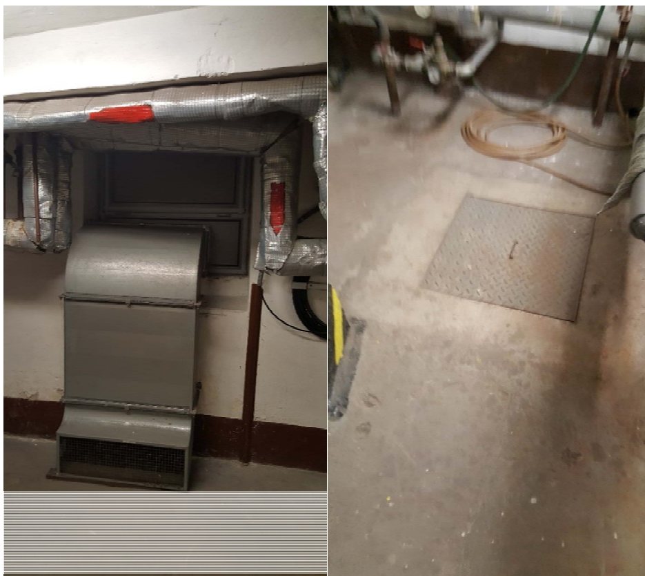
Obrázok č.35 a 36 – Pohľad na odvetranie kotolne a pohľad na revíznú šachtu vodovodu, ktorý má ležaté rozvody pod terénom (miestnosť 0.04)
